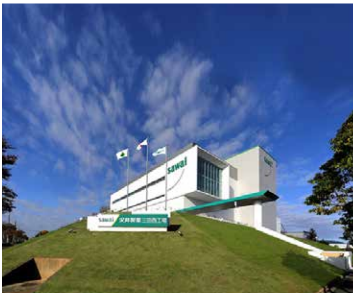
三田西工場外観
