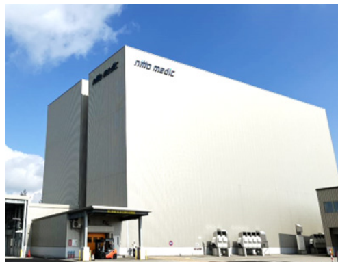
第5 倉庫棟外観
